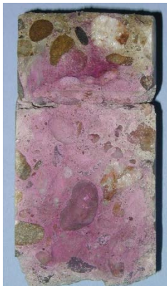
Figuur 4: Bepaling van de carbonatatie diepte op een boorkern
