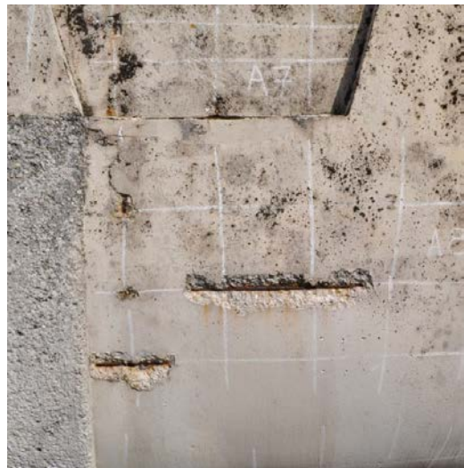
Figuur 3: Bepaling van de locatie van de wapening met een pachometer
