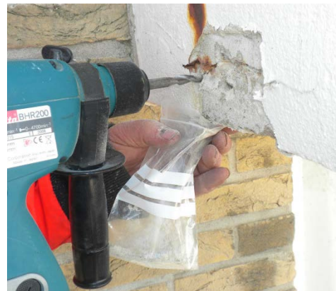
Figuur 5: Het ontnemen van boorstof voor de bepaling van het chloridegehalte
