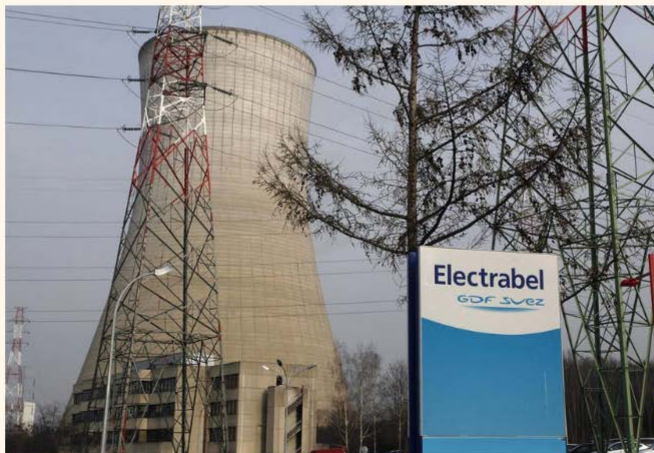
De elektriciteitscentrale van Electrabel Engie in Tihange. ©AFP
