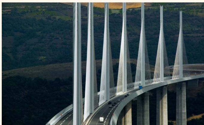
Het bekende viaduct van Millau in Frankrijk zit propvol sensortechnologie om de veiligheid te garanderen. © TARN VALLEY/BELGA
