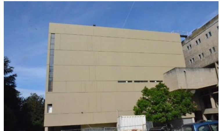
Voor herstelling (boven) & na herstelling + carbonatatieremmende coating (onder)
