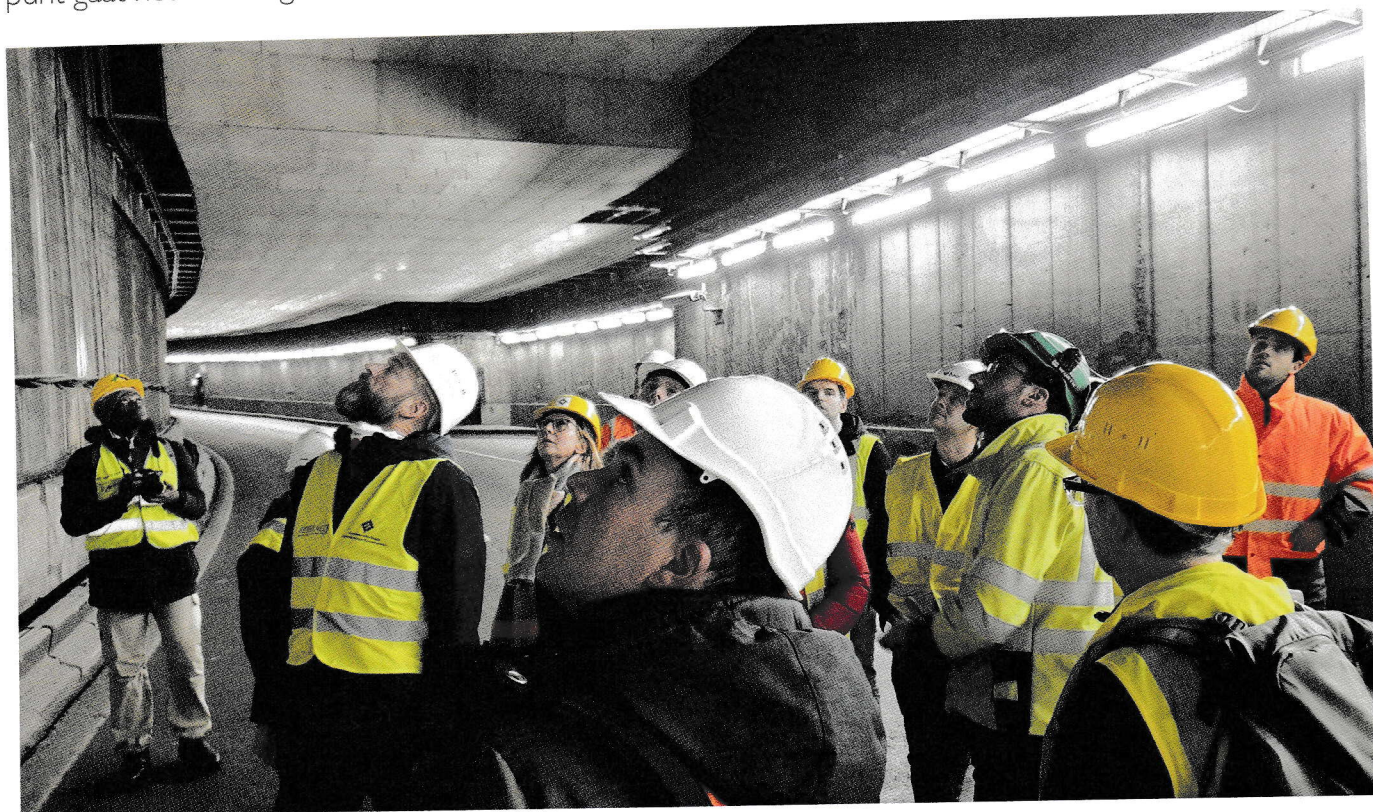
Een kleine groep onderzocht onlangs het betonherstel aan de Leopold II-tunnel in Brussel.
