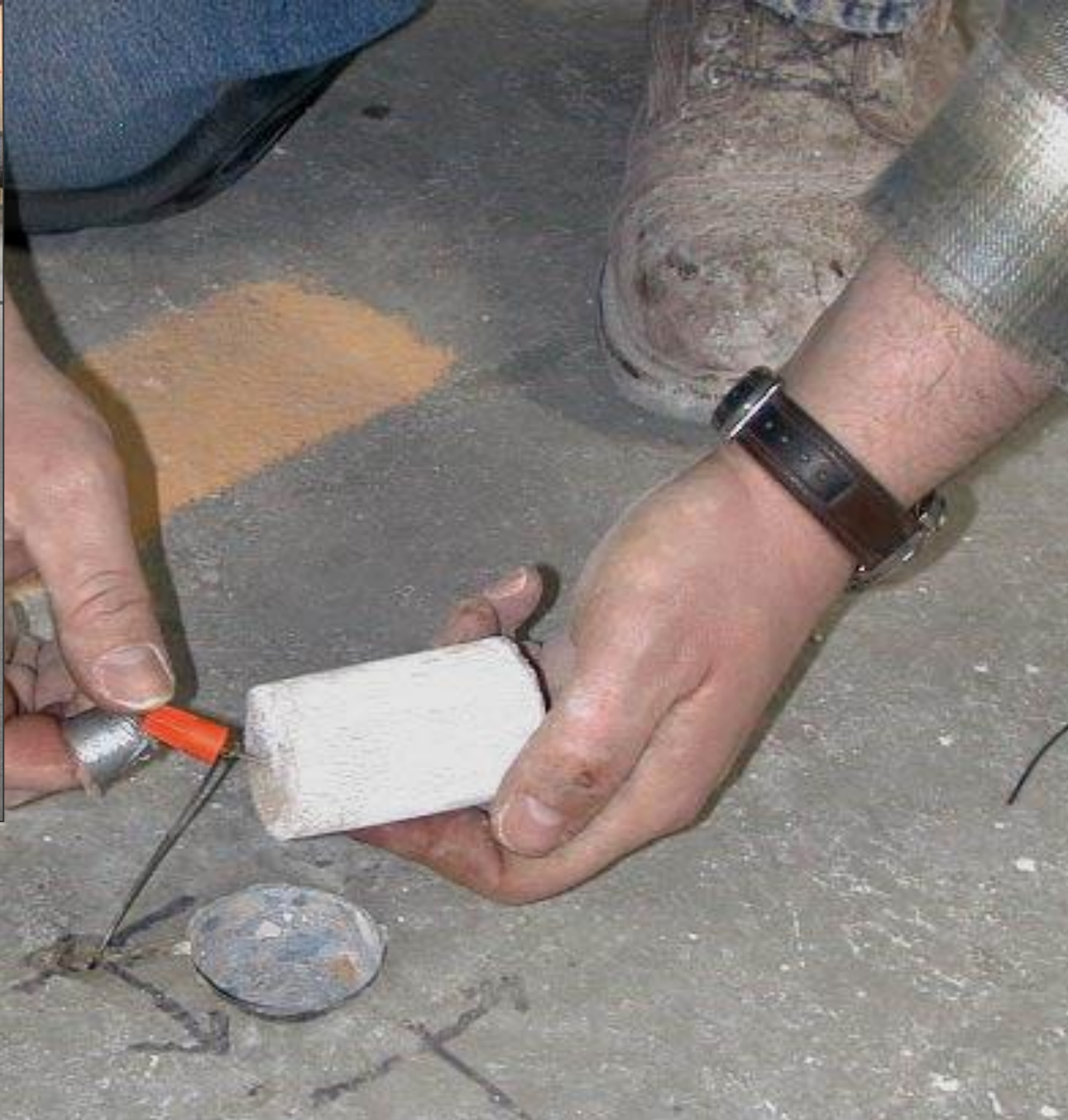
Anode aansluiting aan de wapeningstaal
